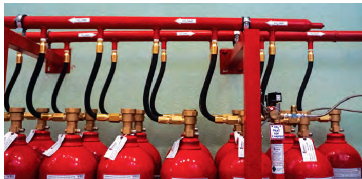
200 Bar Inert Sistemi Örneği
