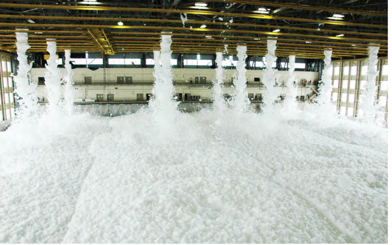
Uçak Hangarları Yüksek Genleşmeli Köpüklü Söndürme Sistemi
