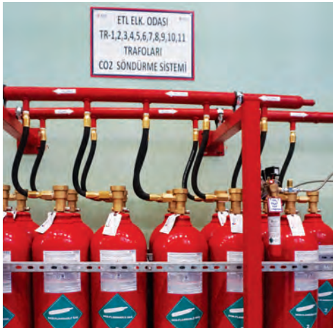
Yüksek Basınçlı CO 2 Sistem Örneği
