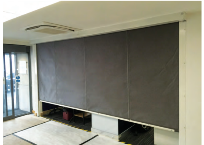
Otomatik Düşey Yangın Perdeleri
