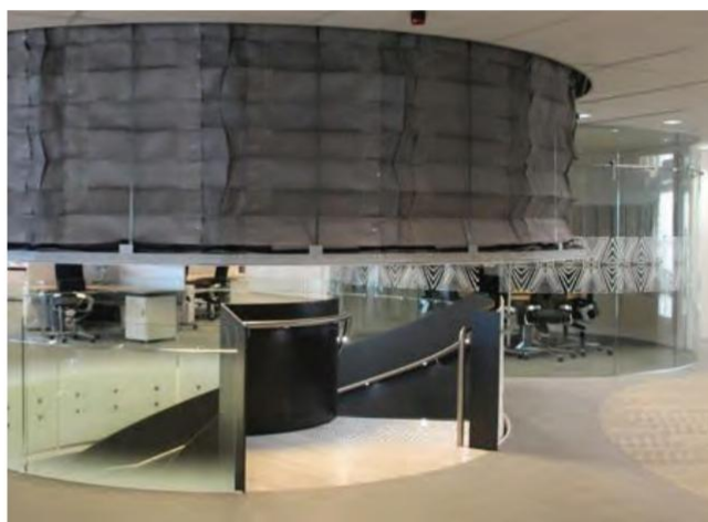
Автоматическая противопожарная завеса типа концерттина
