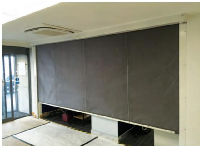
Автоматическая вертикальная противопожарная завеса
