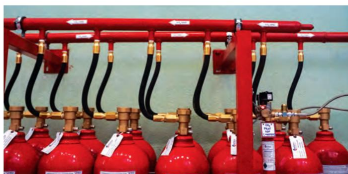
Образец Инертная система 200 бар
