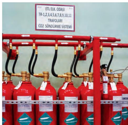
Образец Система CO2 высокого давления
