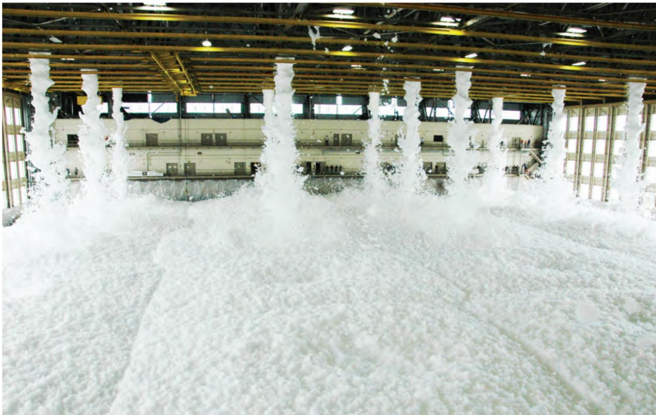
Система пенного пожаротушения высокой кратности в ангарах для самолетов
