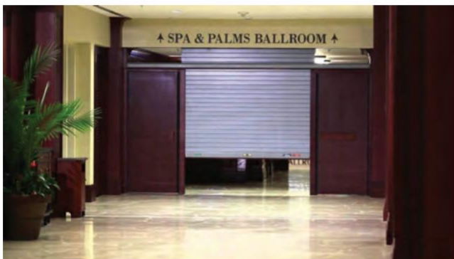
Интегрированные (Т) противопожарные двери с рольставнями и противопожарными дверями для пешеходных переходов
