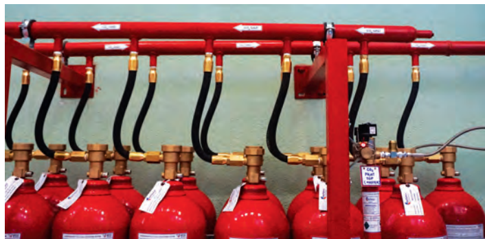
200 Bar Inert Sistemi Örneği
