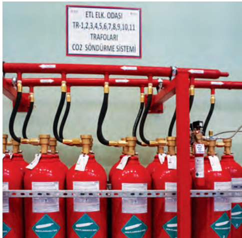
Yüksek Basınçlı CO 2 Sistem Örneği
